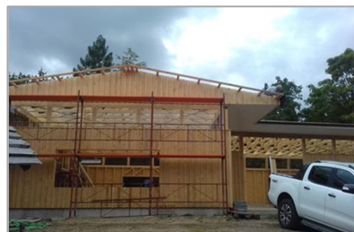
Abb.: Der neue Scheunentrakt bei der Dachgleiche am 13.08.2019
